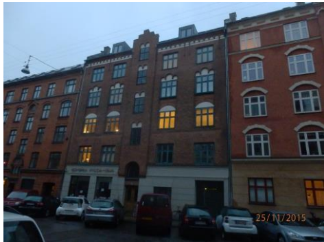
Ægirsgade 49, opført 1902 Boliger 1.039 m 2 , erhverv 120 m 2 .
