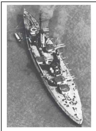
HMS Tiger 1914, slagkrydser, 110.000 hk, 29 knob, 8 stk. 13½ tommers kanoner, max vandlinje panser 9 tommers.
